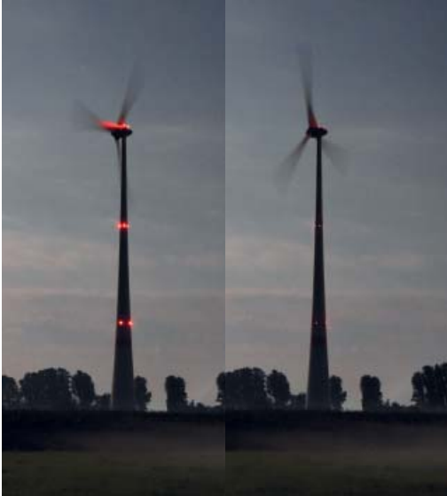
Befeuerungskonzept ARC-SIRIL Obstacle lighting concept ARC-SIRIL
